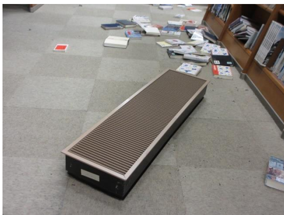
天井/上部の部品破損・落下
